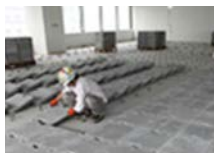
④パネル敷き込み
