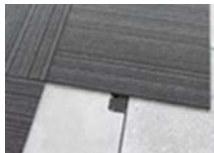
⑥カーペット敷き込み
