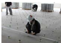
②支柱レベル調整
